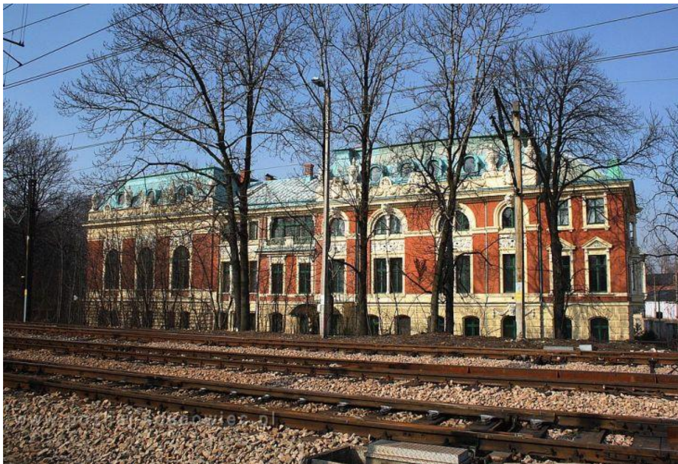
Pałac Dietla w którym założono szkołę baletową.
