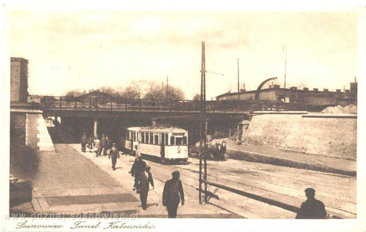
Sosnowiec, Tunel Katowicki na ulicy Piłsudskiego.
