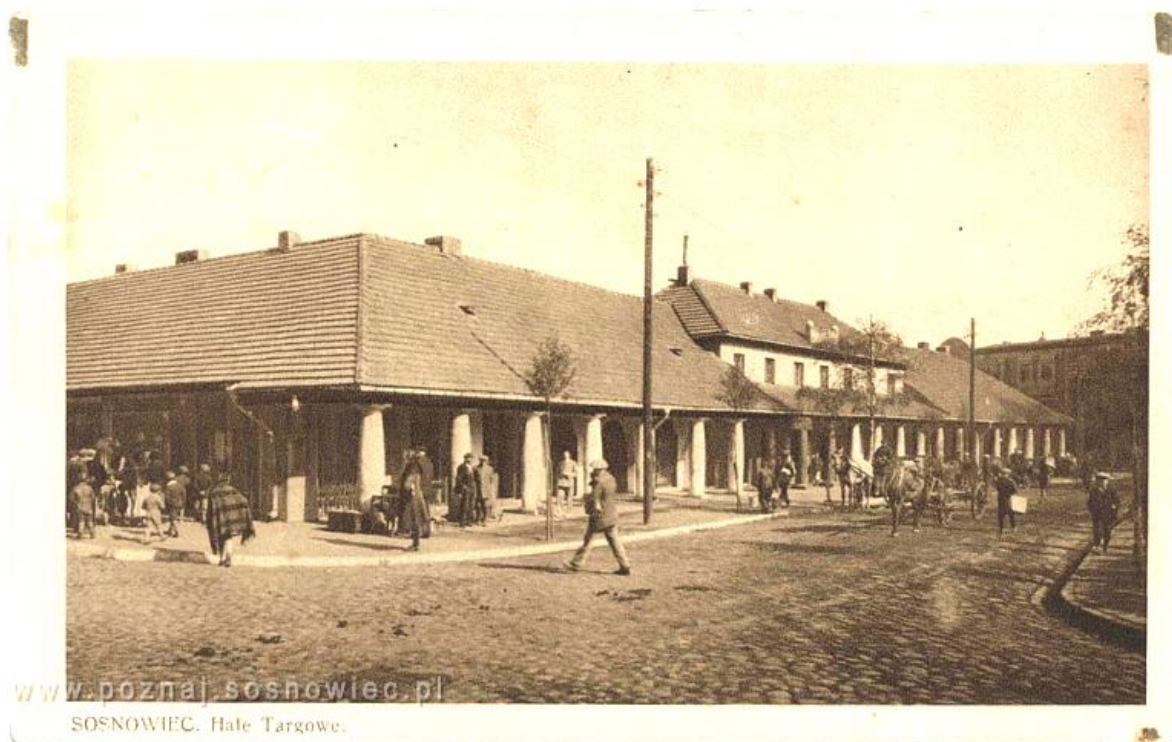
Hale targowe w Sosnowcu przy ulicy Kościelnej, szkoda, że już wyburzone.
