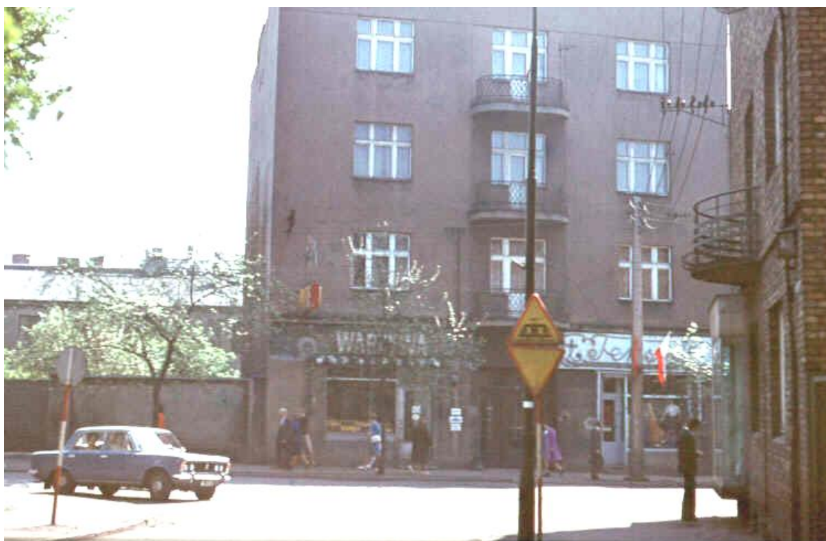
Dom Hessego (po przebudowie) przy ulicy Orlej 11. (Foto 1975.05.01)
