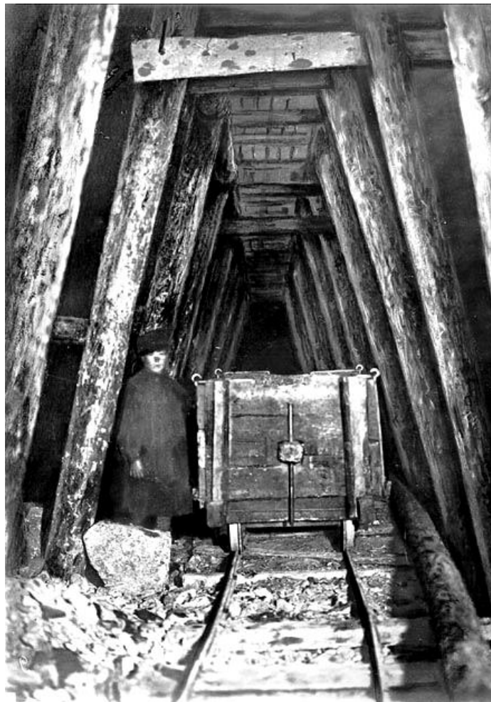
maj 1904 roku – budowa tunelu „Tolstyy” i tunel „Katorżniczy” – ręczna robota zesłańców
