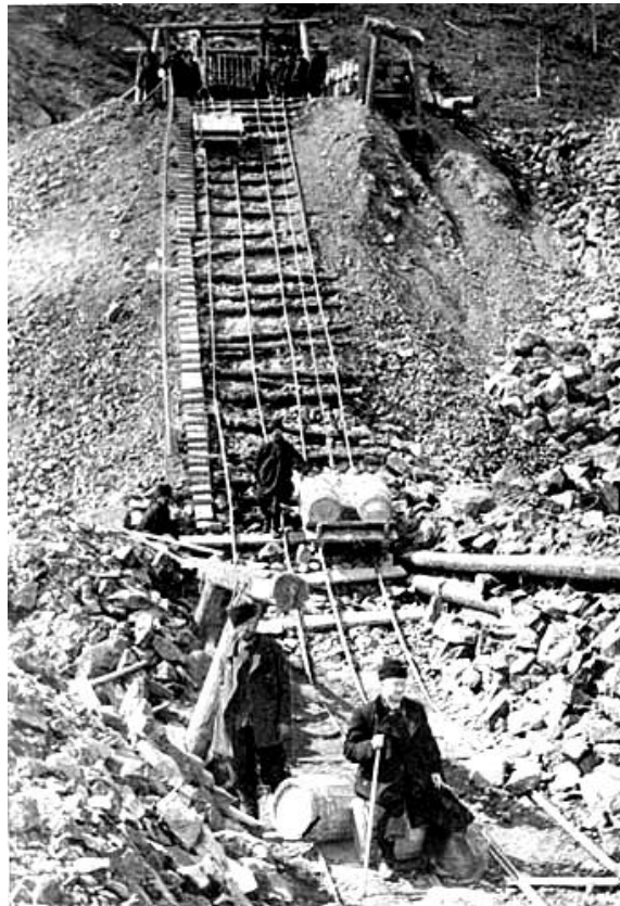
1902—1904 ręczna robota katorżników – wciąganie beczek z cementem i wodą
