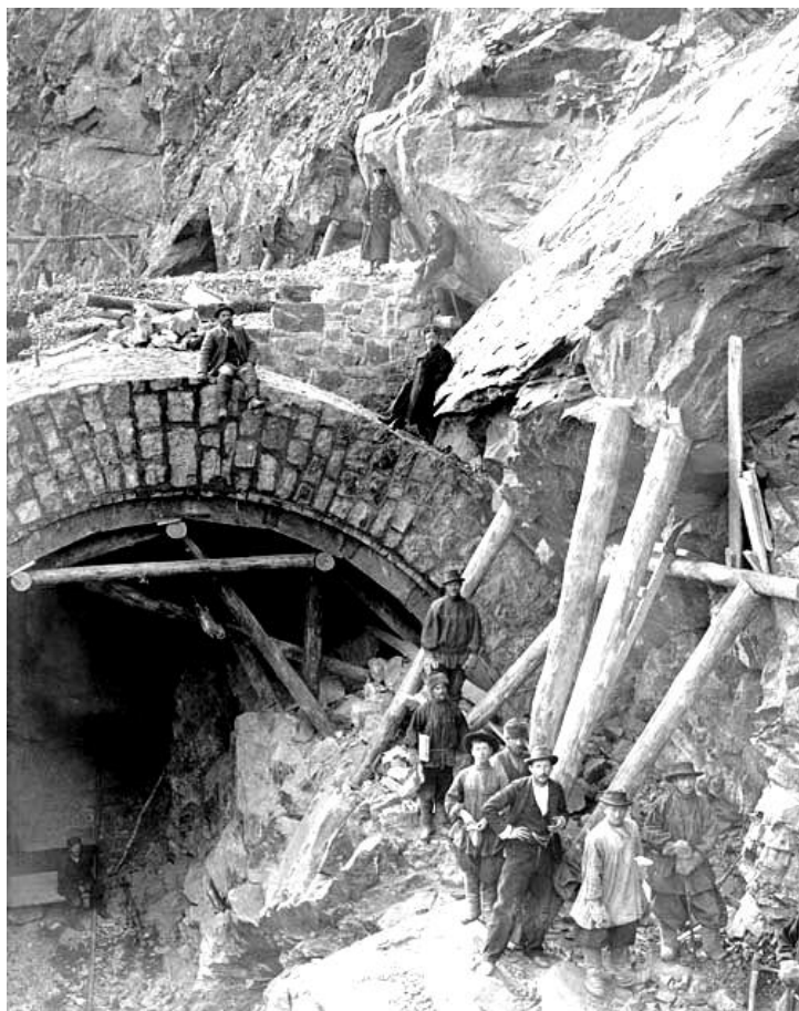
wrzesień 1904 roku – nad Bajkałem – tunel nr 5 – ręczna robota zesłańców
