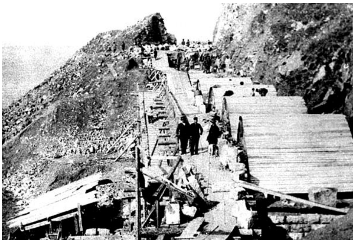
1903—1905 rok „Guba Upornaja” – budowa kamiennego wiaduktu
