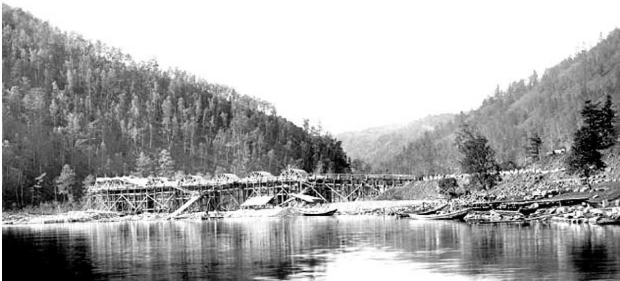
sierpień 1903 roku – rzeka Angasołka – budowa wiaduktu
