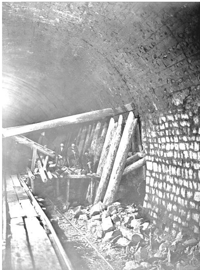
maj 1904 roku – budowa tunelu „Tołstij” i tunel „Katorżniczy”
