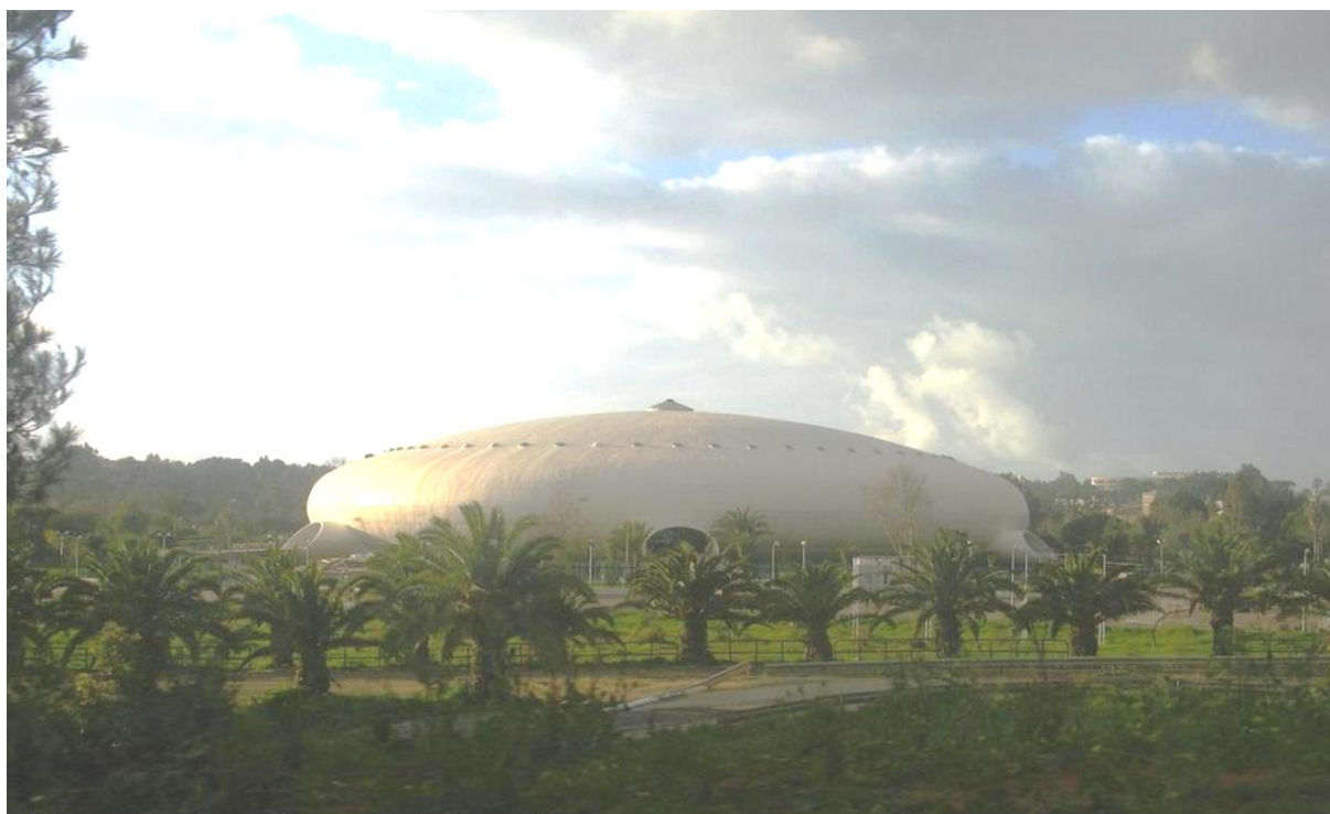
Łupinowa konstrukcja hali – autor Oscar Niemeyer, Alger, Algeria. (Foto 1984)
