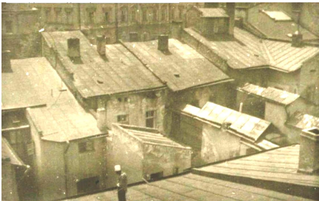
Przemyśl, widok z dachu domu, który inwentaryzowaliśmy. Pośrodku wolnostojące piętrowe klozety nieskanalizowane dla mieszkańców,
