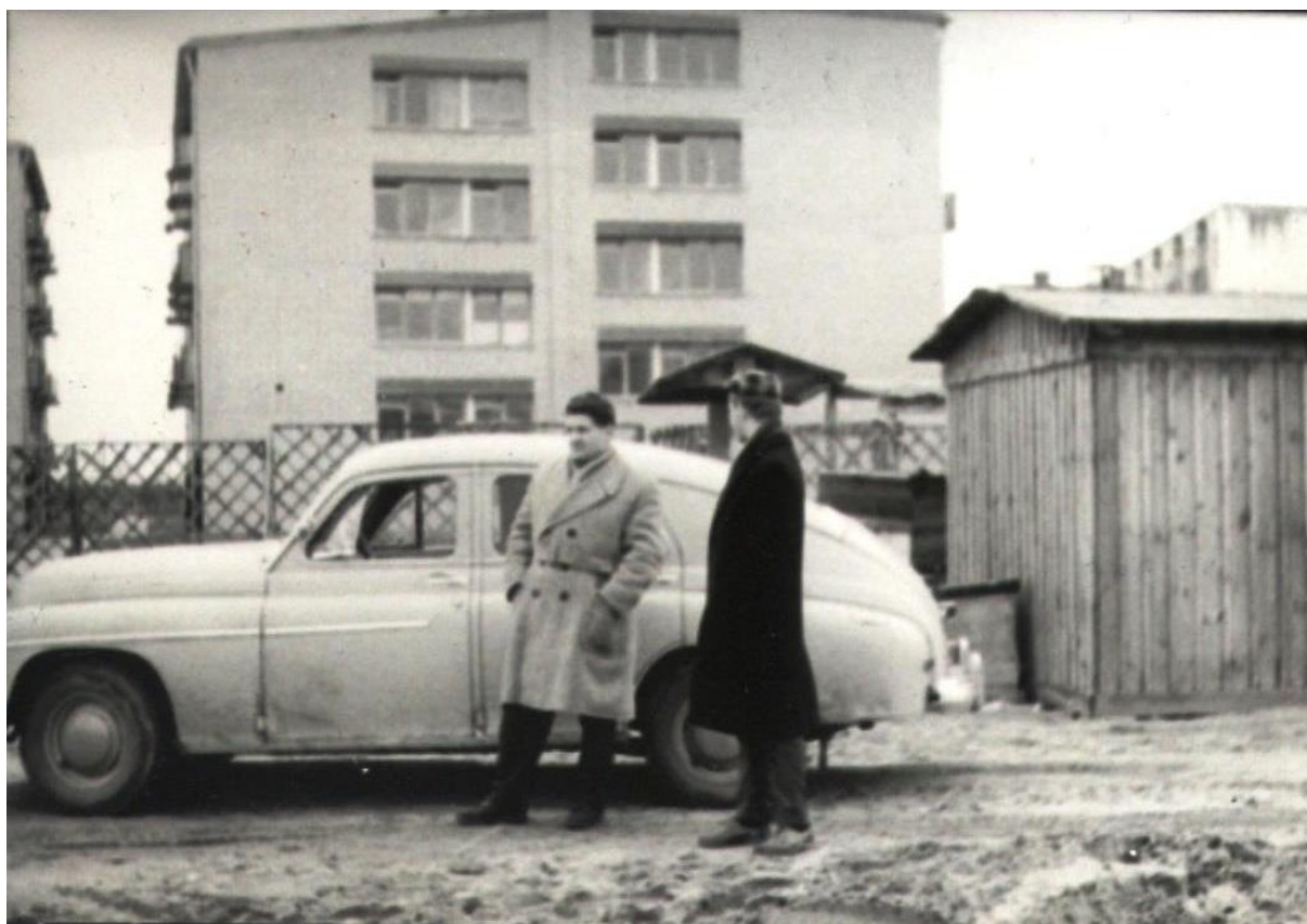
Na budowie osiedla Bielany III, 1963 rok.
