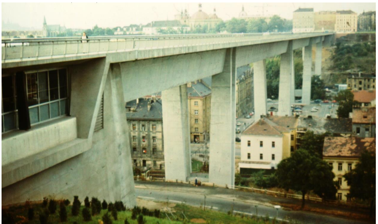
Praga, Most Nuselski (w 1975 roku Klementa Gotvalda) w którym na dolnym poziomie jest tunel metra, a wyżej trasa samochodowa – 08.10.1975 roku.
