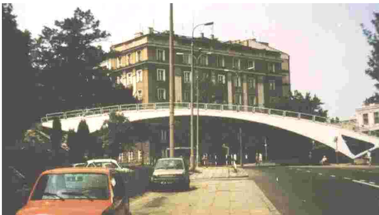
Kładka dla pieszych nad ulicą Górnośląską obok Sejmu w Warszawie.
