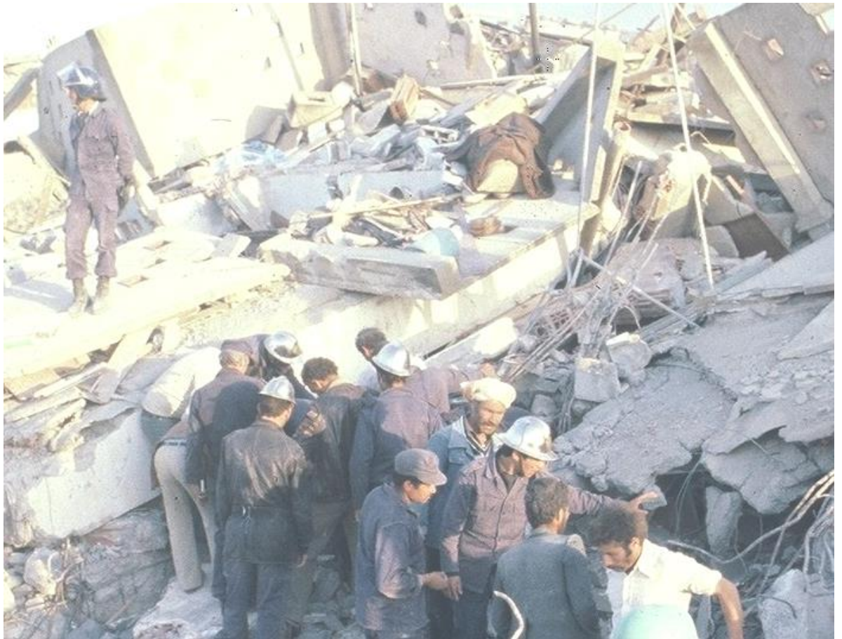
El Asnam – skutki trzęsienia ziemi w dniu 10 października 1980 roku.
