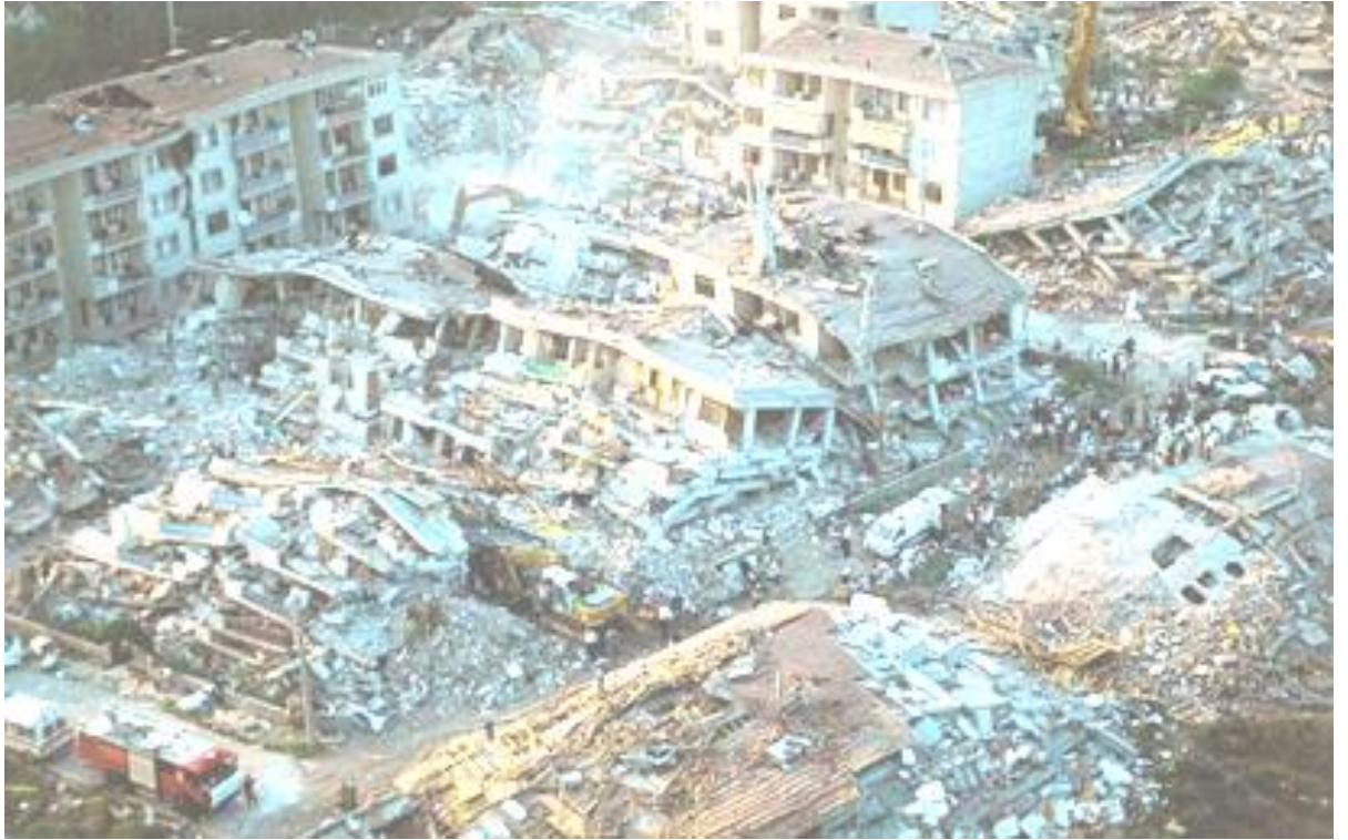
El Asnam – skutki trzęsienia ziemi w dniu 10 października 1980 roku.
