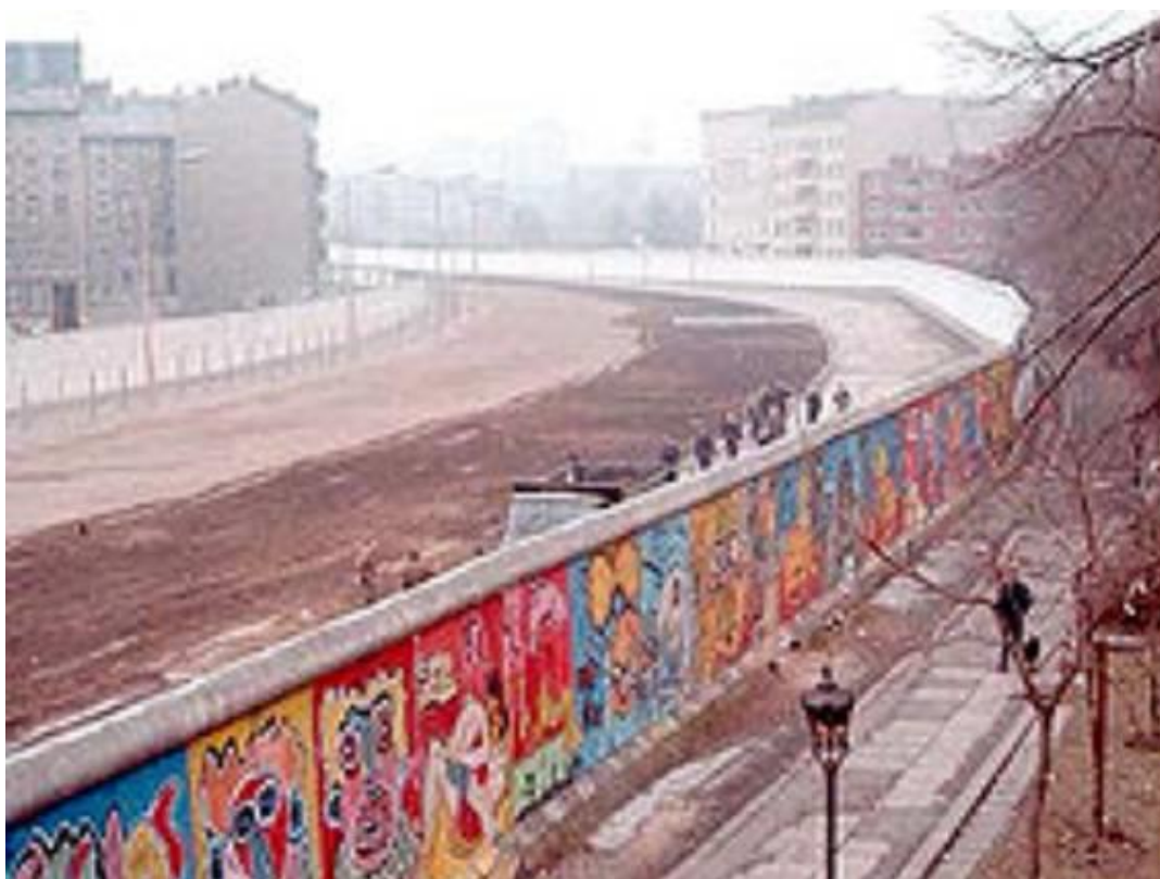
Widok od strony Berlina Zachodniego na mur i strefę śmierci.
