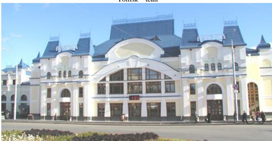
Tomsk – dworzec kolejowy
