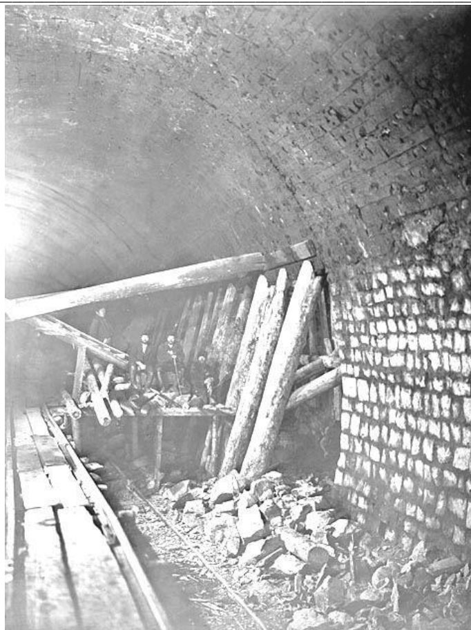
maj 1904 roku – budowa tunelu „Tolstij” i tunel „Katorżniczy”
