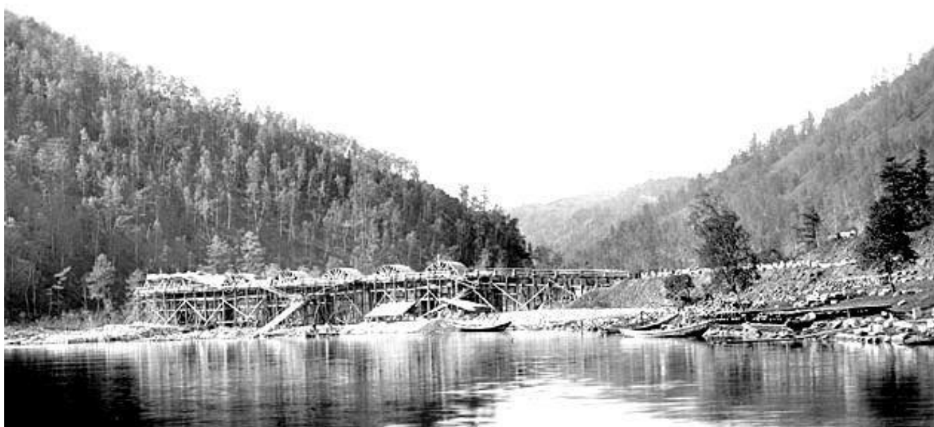
sierpień 1903 roku – rzeka Angasołka – budowa wiaduktu
