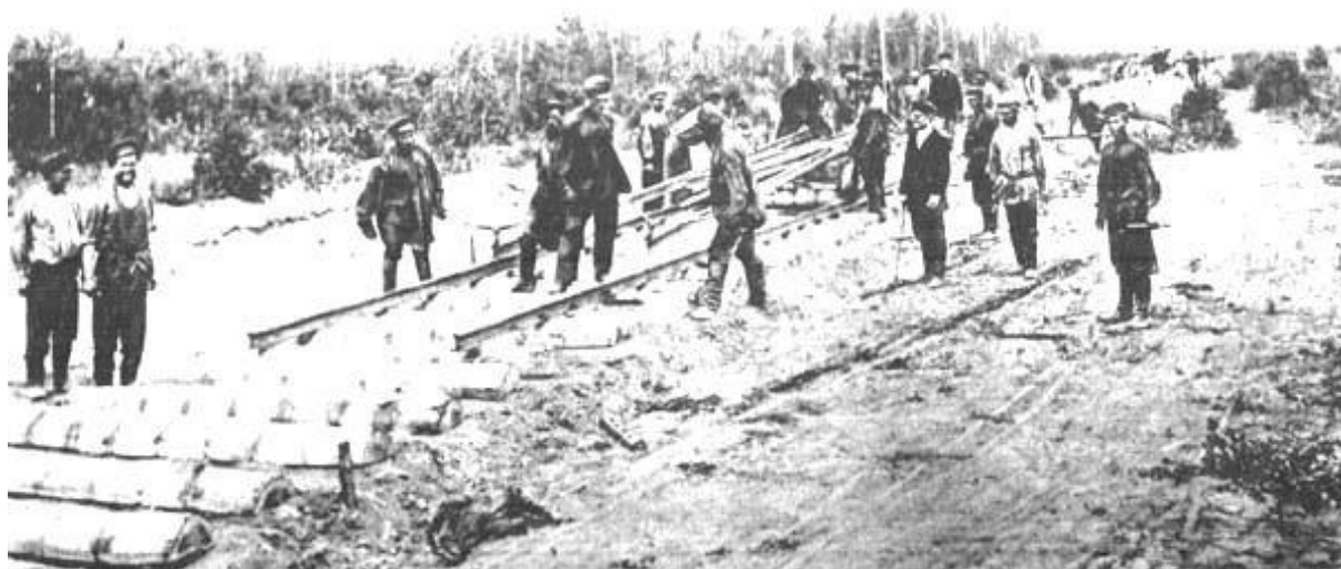
początek XX – wieku: układanie torów
