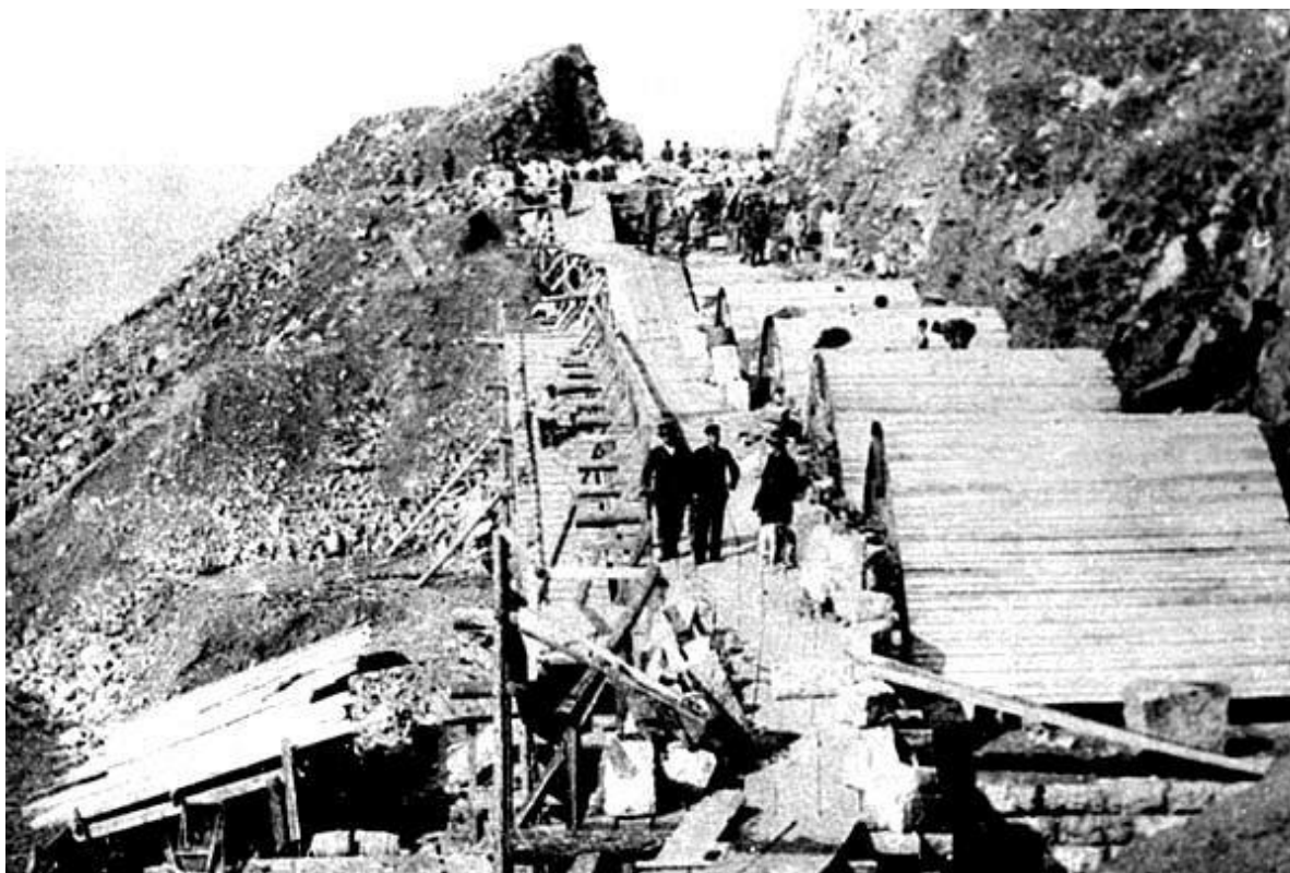
1903—1905 rok „Guba Upornaja” – budowa kamiennego wiaduktu
