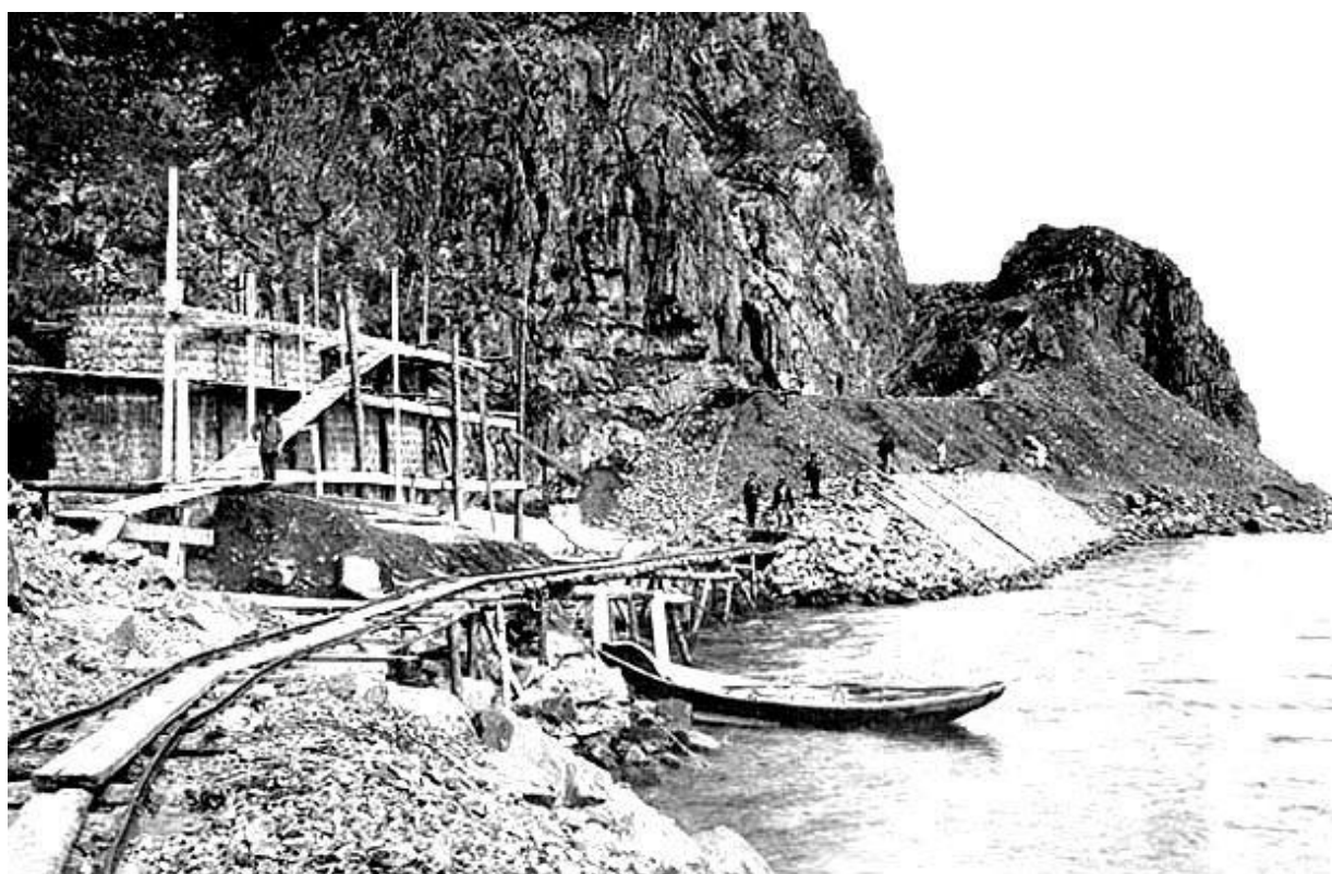
sierpień 1903 roku – ściana oporowa i tunel nr 3
