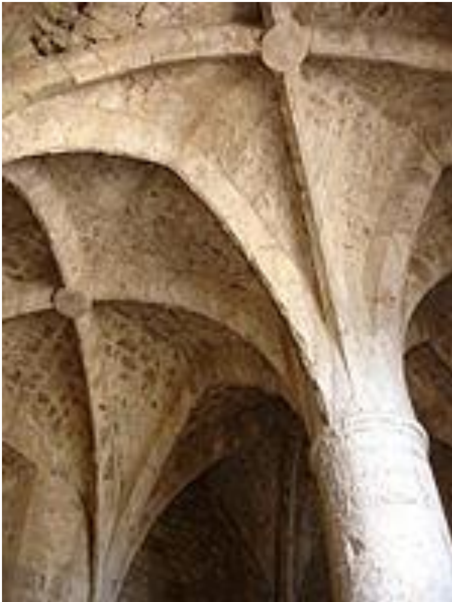
Sklepienie krzyżowo-żebrowe ze zwornikiem, Francja, Chateau de Queribus – 1020 rok.
