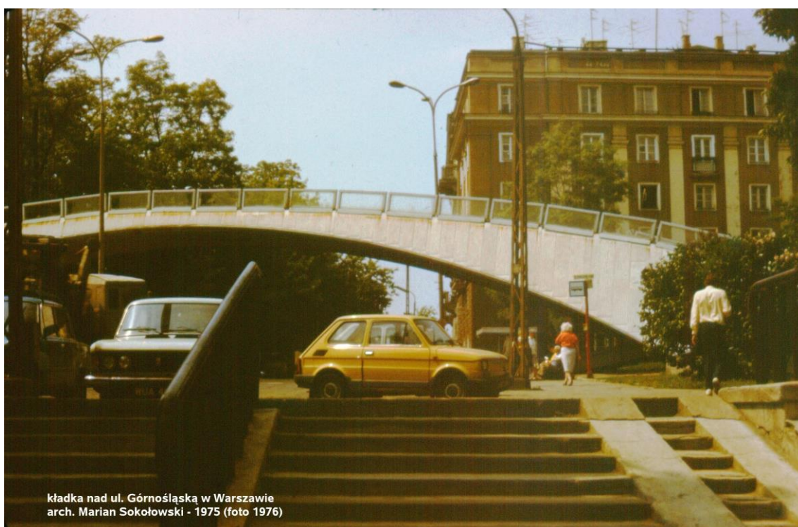
kładka nad ul. Górnośląską w Warszawie arch. Marian Sokołowski - 1975 (foto 1976)
